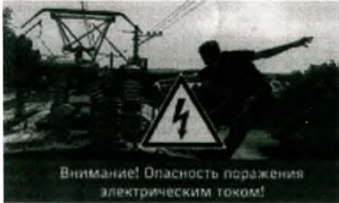
Напряжение контактной сети - 27500 вольт
